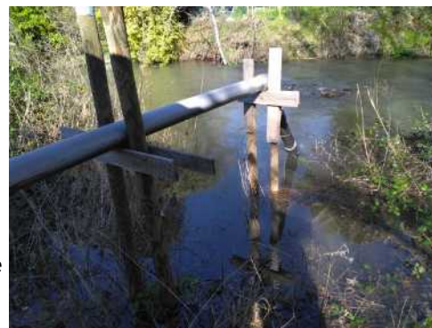
Vous voyez ici le tuyau d'aspiration de la pompe principale. En temps normal les poteaux à gauche sont à plus d'un mètre au dessus du niveau d'eau du bras de Sorgues.
